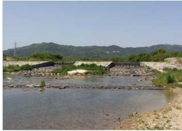
嘉瀬川石井樋大井手堰
